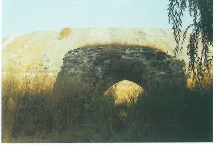
Res.8: Dört ayaklı yapının yakından görünüşü.
