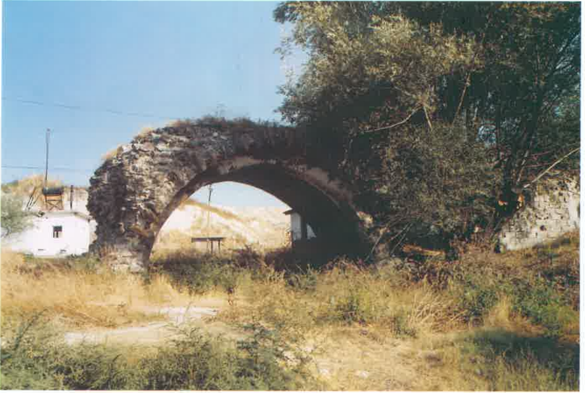
Res.6: Keykubadiye Sarayı kalıntılarından kemerli yapı.
