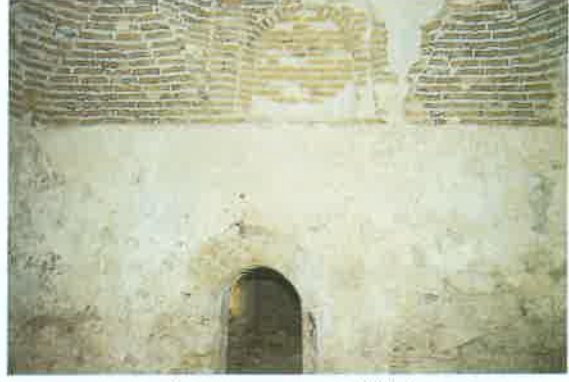
Lev. 13: Balta Bey Hamamı, ılıklik, batı duvar.
