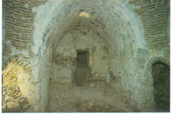
Lev. 15: Balta Bey Hamamı, sıcaklik, batı eyvan.
