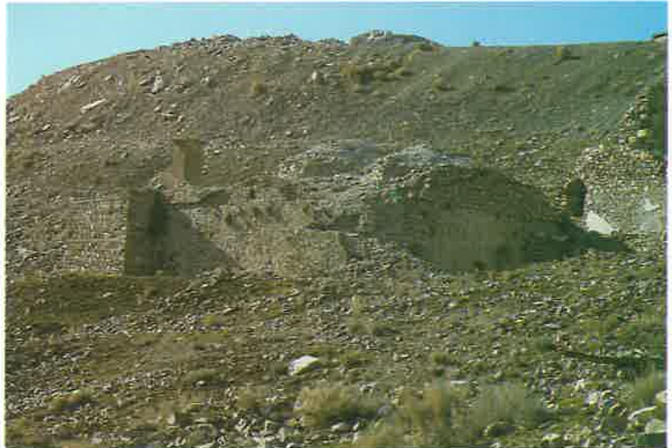
Lev. 4: Balta Bey Hamamı, güneydoğudan görünüm.
