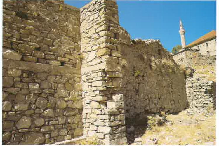
Lev. 6: Balta Bey Hamamı, güney cephe ayrıntı.
