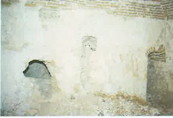
Lev. 12: Balta Bey Hamamı, ılıklik, kuzey duvar.
