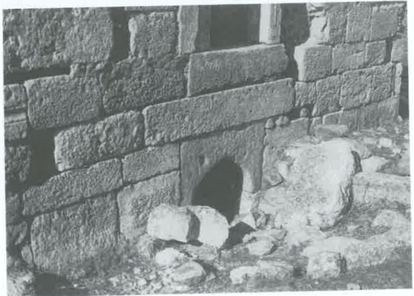
Res. 12: Altınekin İsimsiz Türbe'nin güney cephesi
