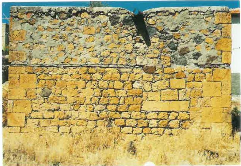
Res. 9: Türbe güney cephesi
