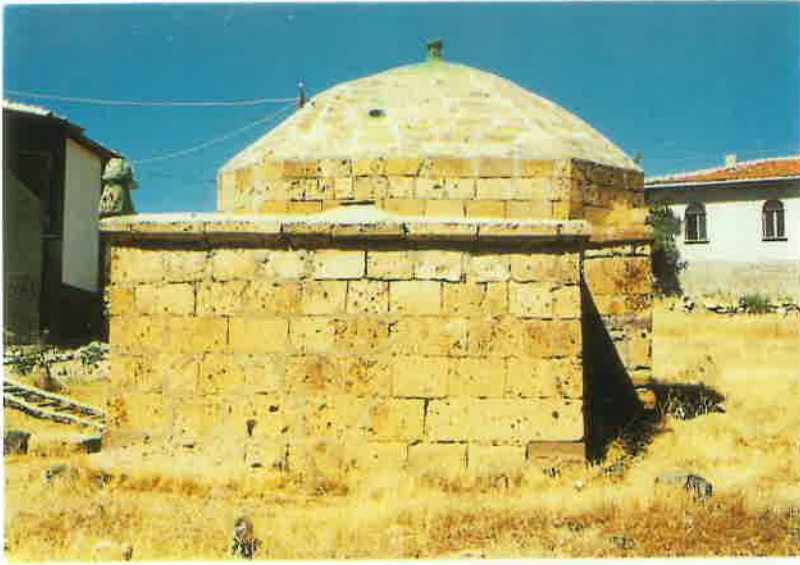
Res. 2: Şeyh İbrahim Kümbeti güney cephesi
