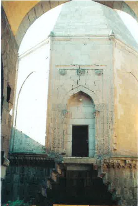
Res. 4: Kayseri Köşk Medrese Türbesi
