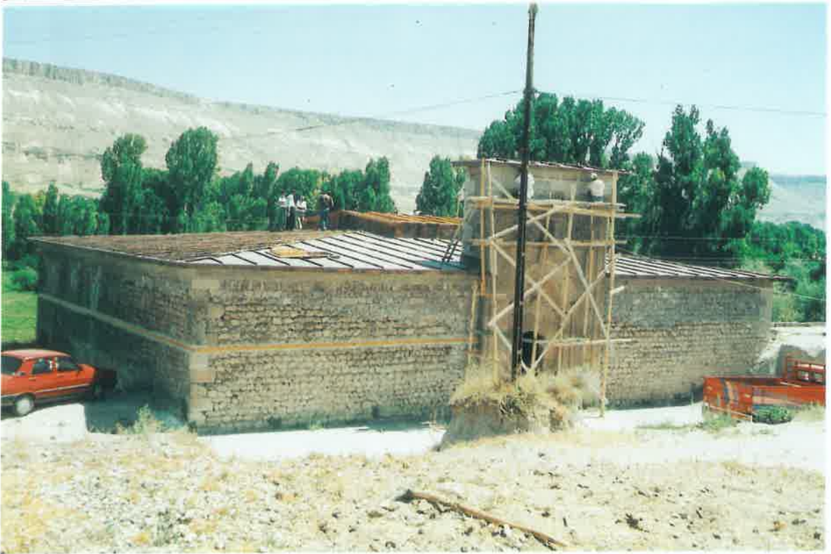
Res. 24: Taşkın Paşa Medresesi, onarımdan sonra
