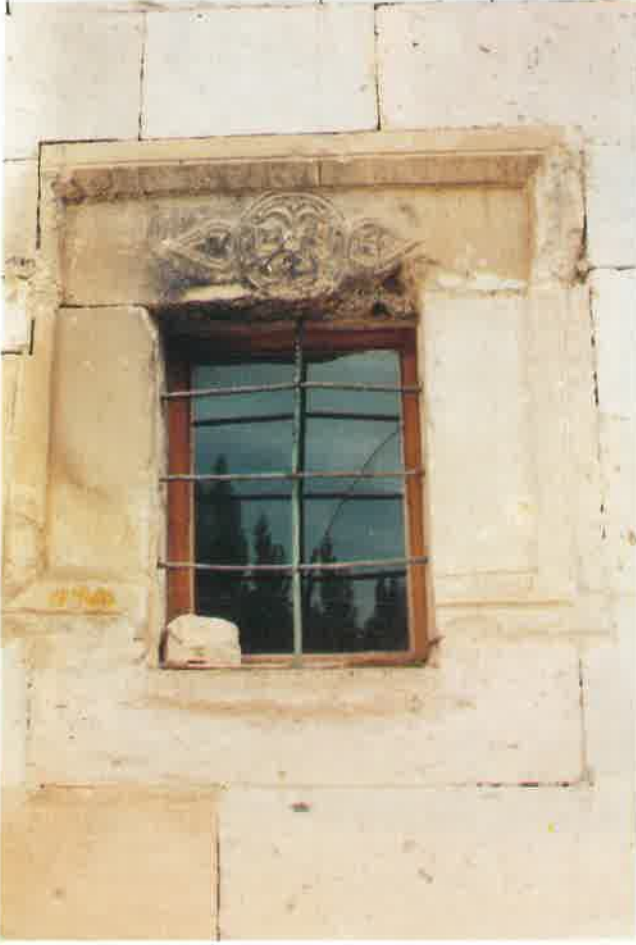
Res. 3: Alaüddevle Camii kuzey cephesinin doğusundaki pencere
