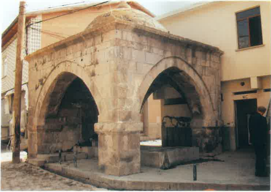
Res. 27: Meydan Çeşmesi'nin genel görünüşü
