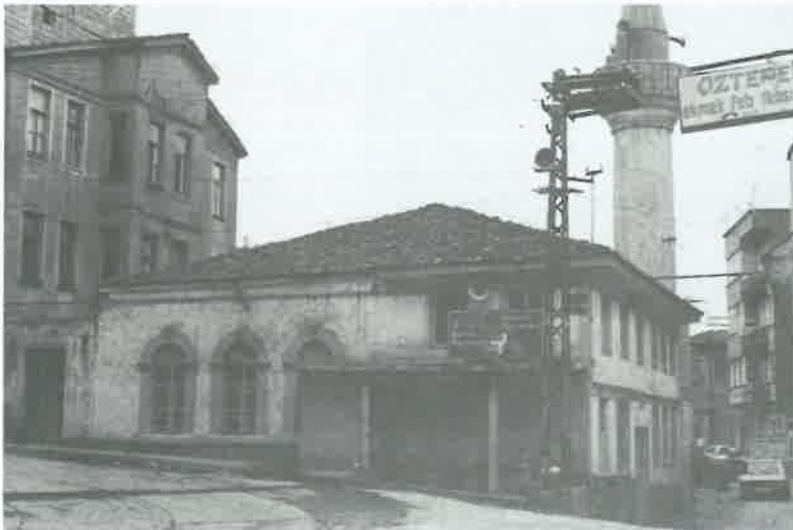
Resim 10: Gözağan Camii'nin yıkılmadan önceki hali.
