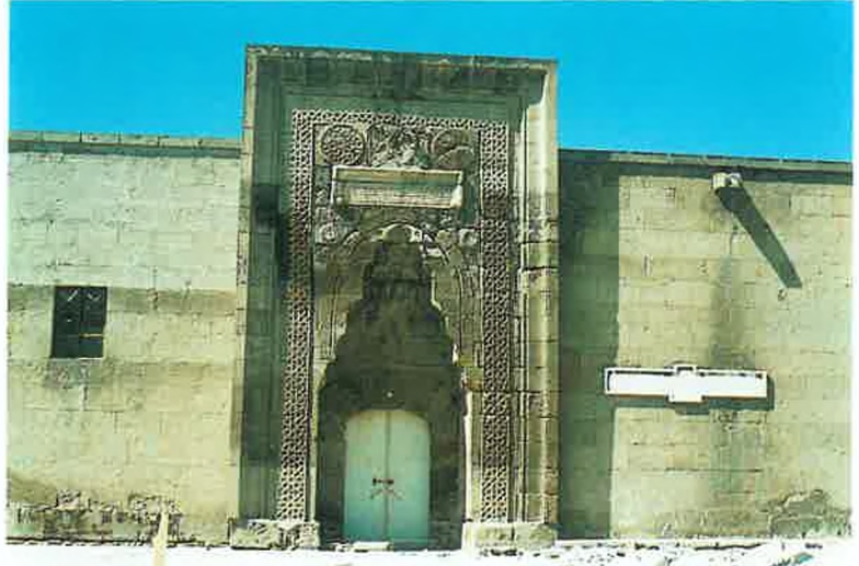
Res. 2: Gevher Nesibe Şifahanesi taçkapısı onarım sonrası görünümü.
