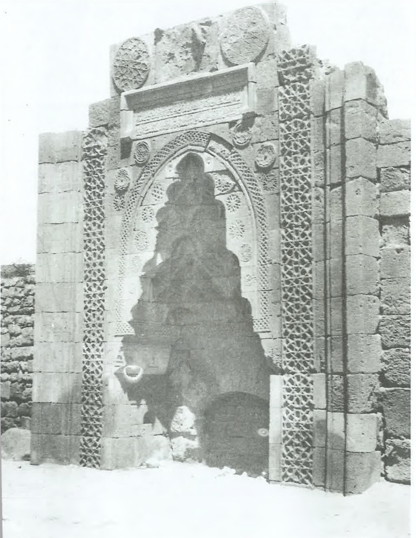
Res. 1: Gevher Nesibe Şifahanesi taçkapisı onarım öncesi görünümü.
