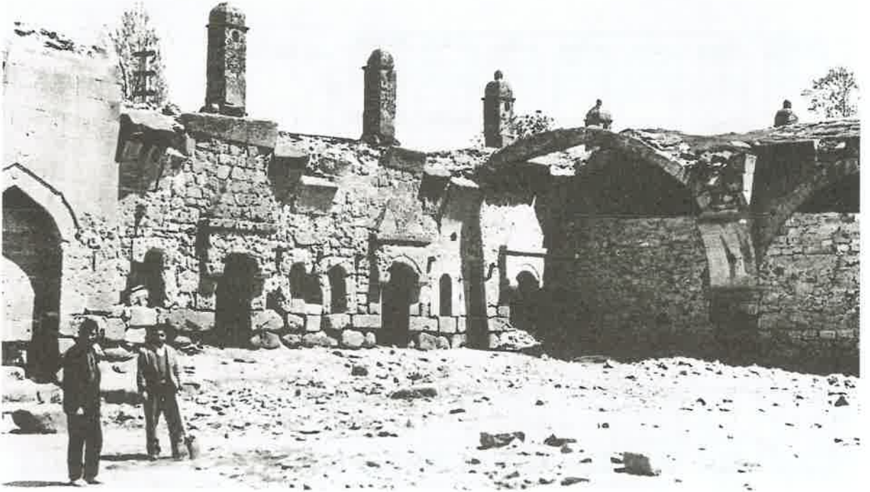
Res. 5: Kervansarayın onarım öncesi görünüşü (1962) (Yılmaz Önge'den).
