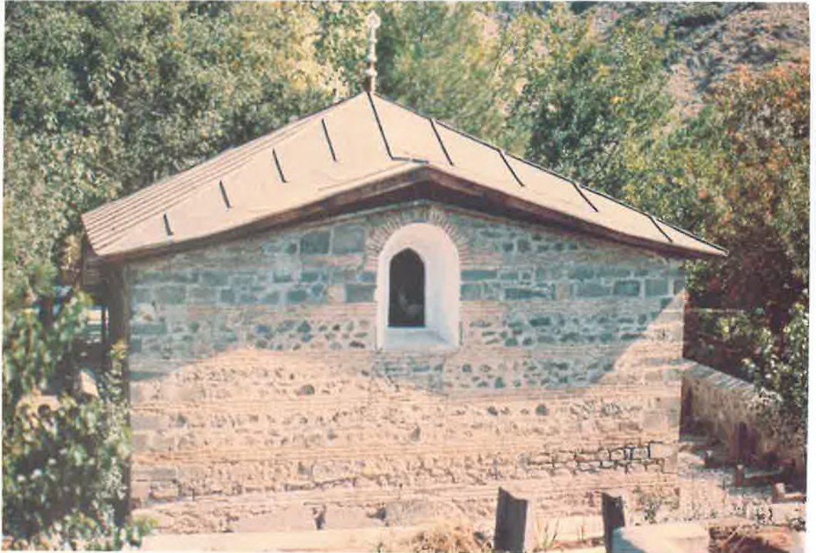
Resim 5: Niksar Melikgazi Türbesi Restorasyon Sonrası 1988 (VGMA)
