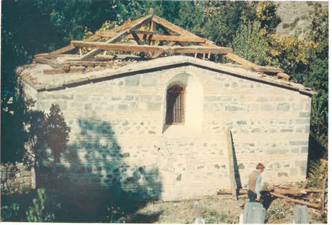
Resim 4: Niksar Melikgazi Türbesi Restorasyon Öncesi 1987 (VGMA)
