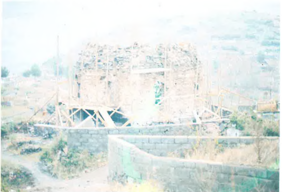
Resim 9: Niksar Kulak Tekkesi Onarım Esnasında (VGM)
