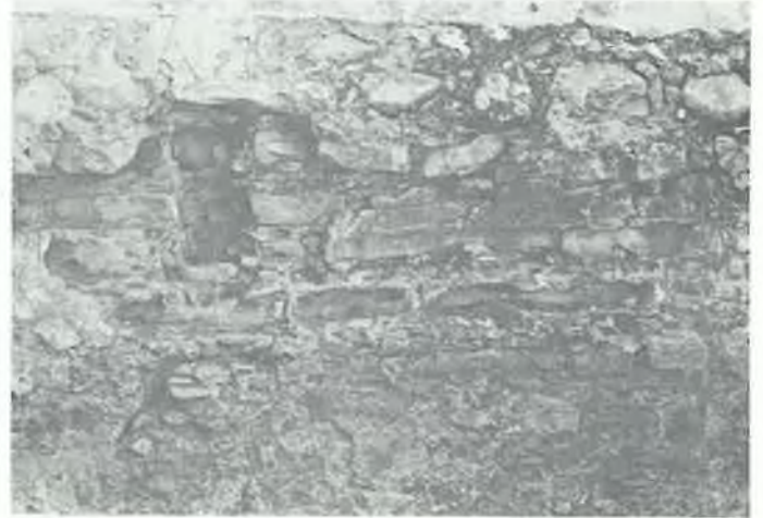
Resim 14: Hamam. Sıcaklıktaki su künkleri.
