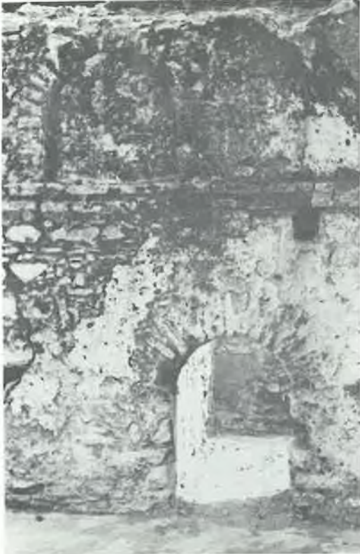
Resim 12: Hamam. Sıcaklığa geçiş kapısı.
