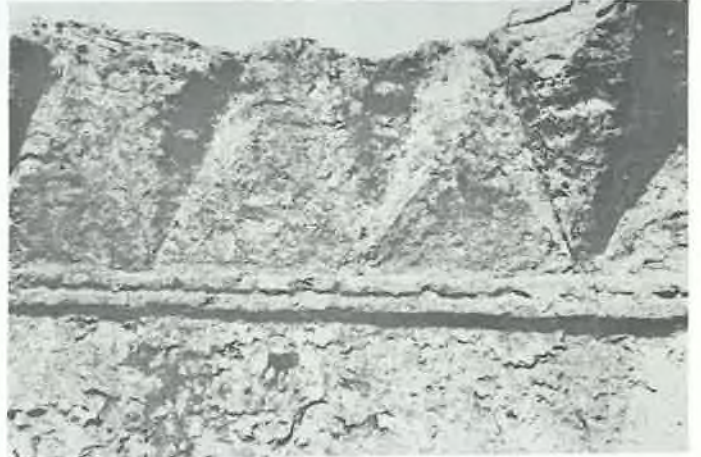
Resim 13: Hamam. Sıcaklıktaki kubbeye geçiş sistemi
