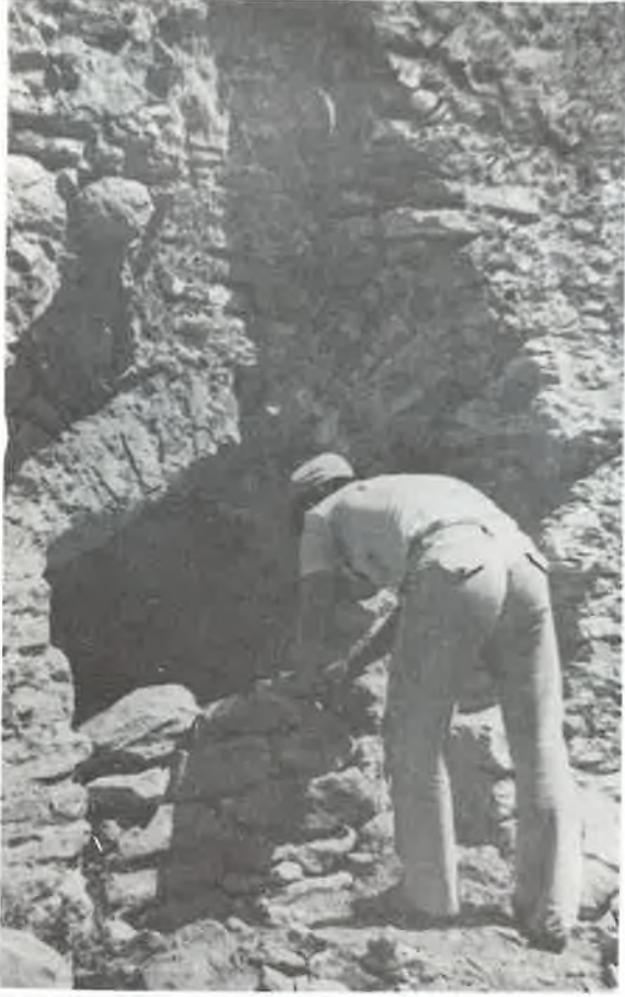
Resim 9: Hamam. Aralık kısmına geçiş ve havalandırma bacası
