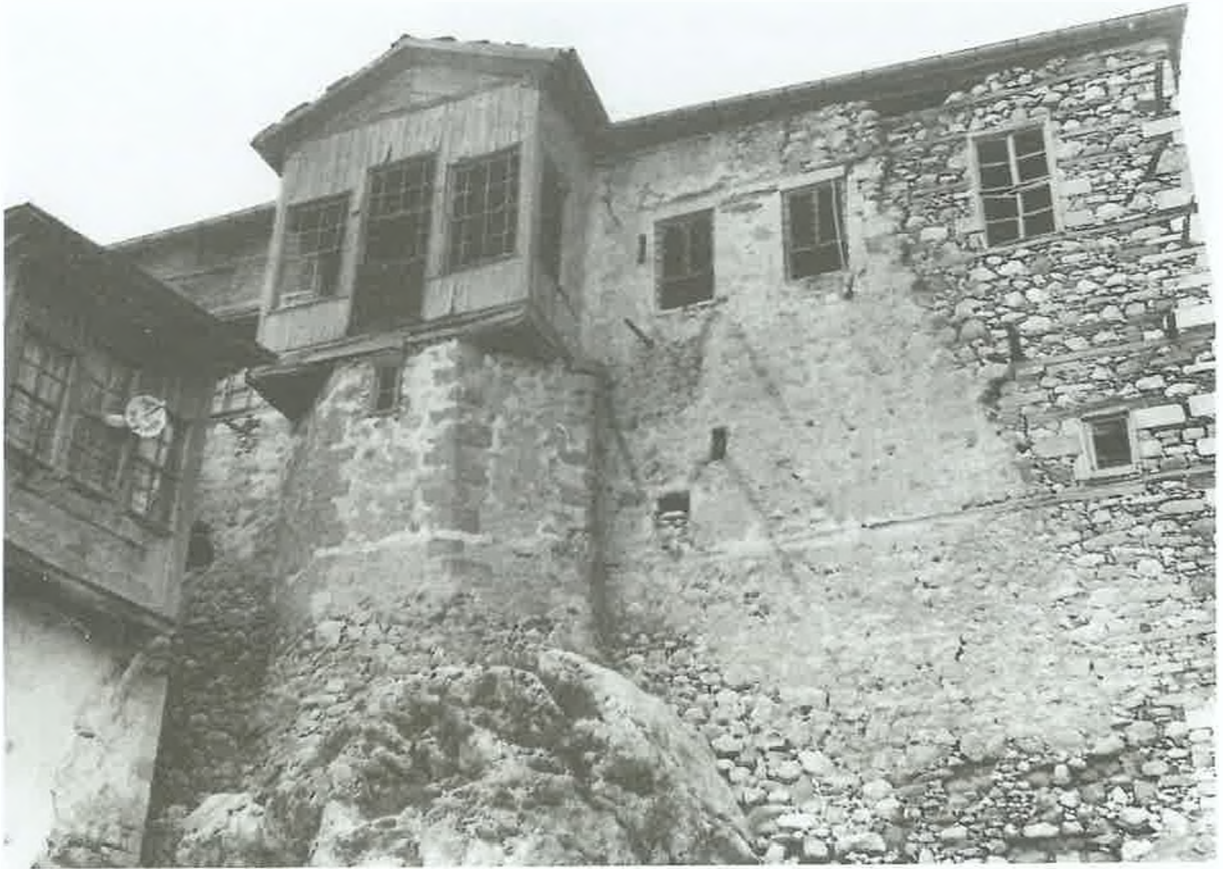
Res. 2: Harput , dış surlarına ait burç.
