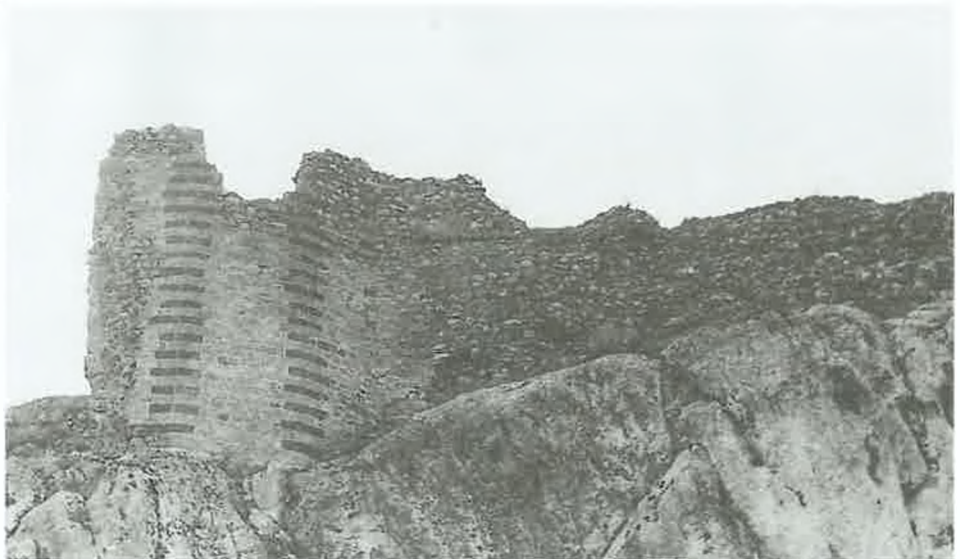
Res. 14: İç kale doğu sur duvarları.
