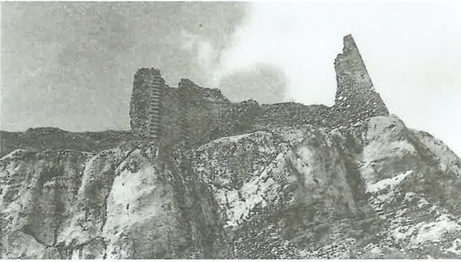
Res. 13: İç kale doğu sur duvarları.
