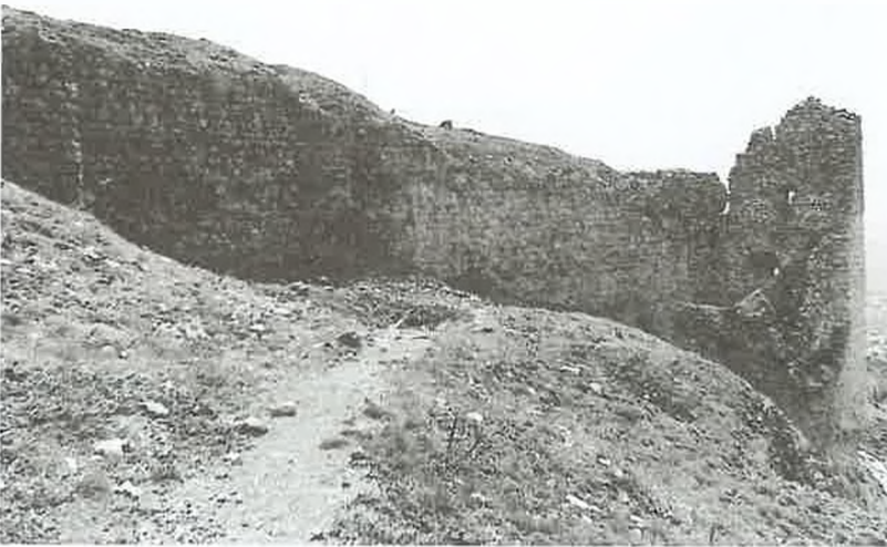
Res. 29: Iç kale batı sur duvarları.
