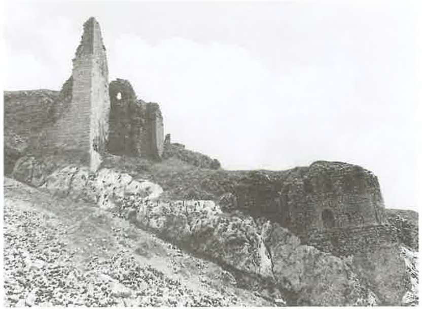
Res. 22: İç kale batı sur duvarları.
