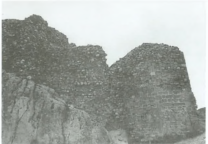
Res. 26: I kale ikinci giriřten sonra doęu'da yer alan sur duvarı.
