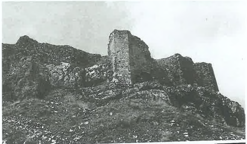
Res. 9: İç kale doğu sur duvarları.
