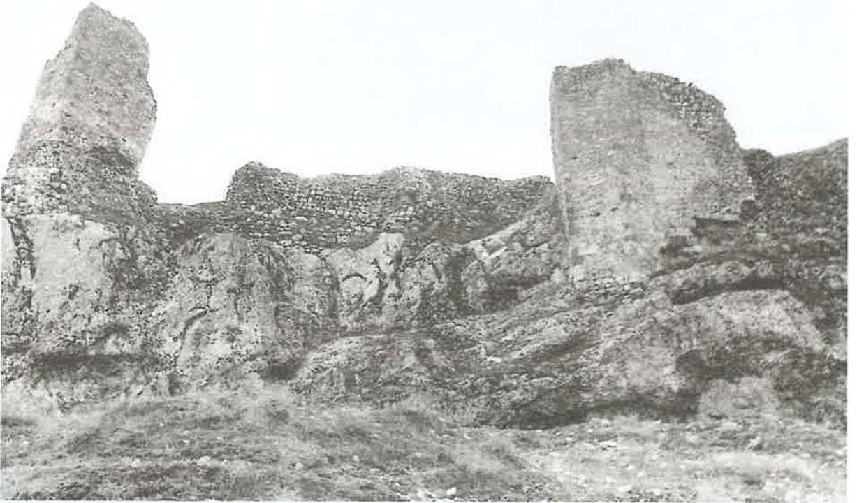
Res. 11: Iç kale doğu sur duvarları.
