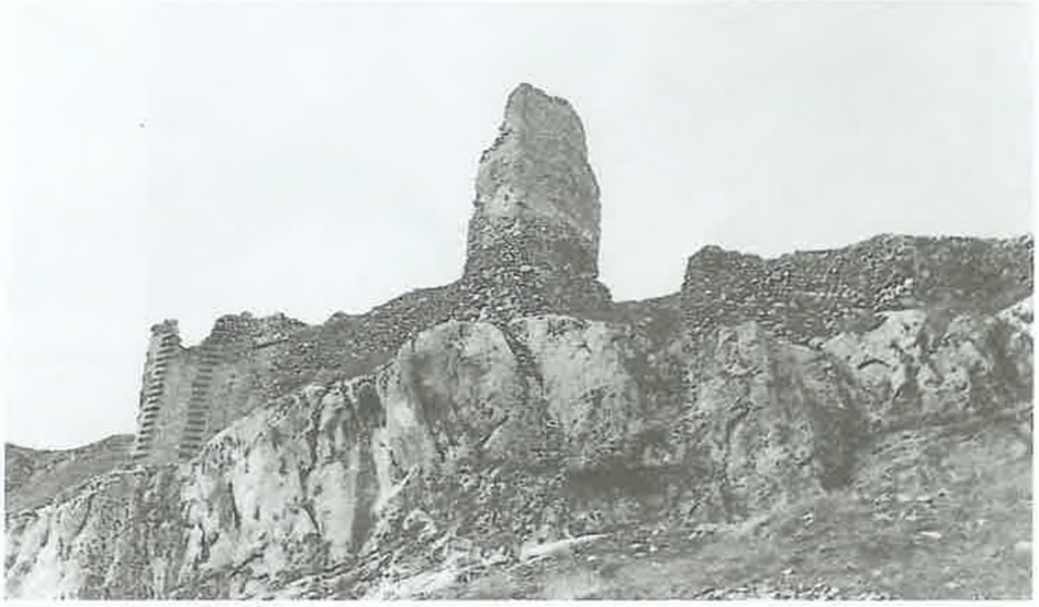
Res. 12: İç kale doğu sur duvarları.
