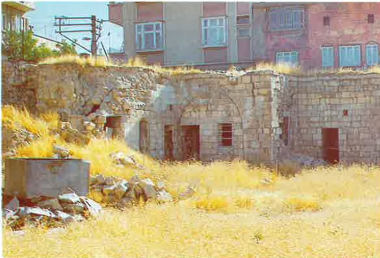
Res. 9: Han, avlunun doğu kenarındaki eyvan.
