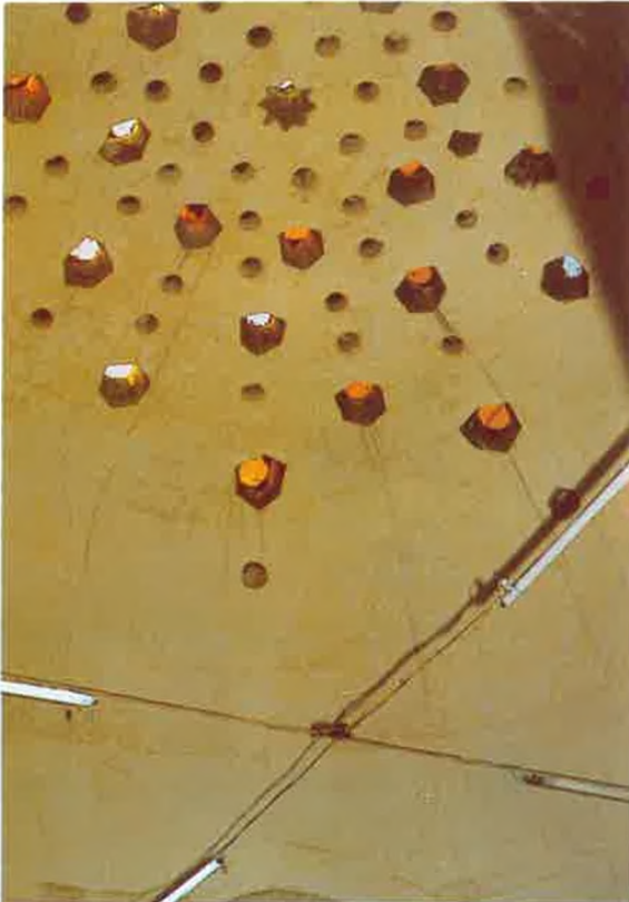
Res. 25: Hamam, sıcaklık kısmındaki merkezi mekânin kubbesi.
