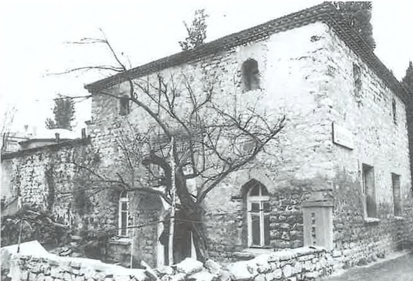
Lev. 60: Gebze, Menzilhane Hamamı, giriş cephesi.
