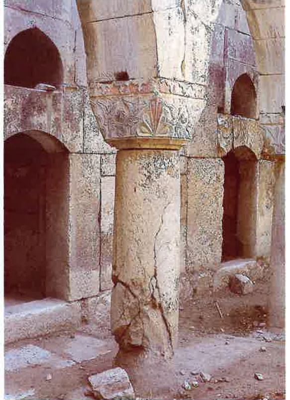
Res.20: Kuzey revakının döşemesinin görünüşü. Res. 22: Güney revakının ortasındaki tehlikeli durumdaki sütun
