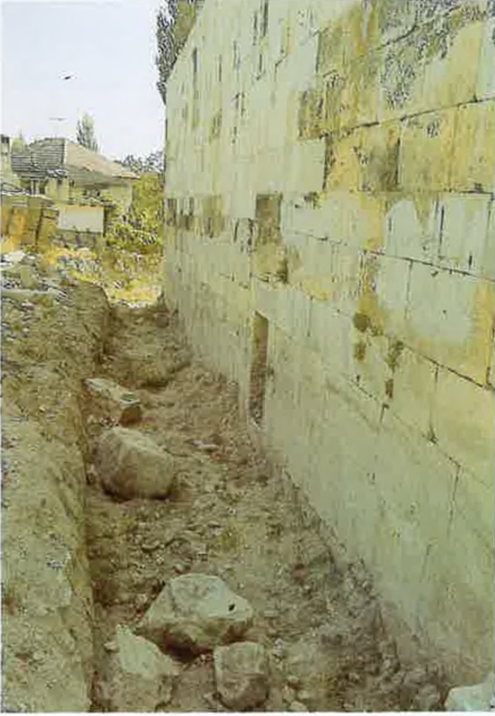
Res. 6: Kuzey cephenin temizlenmiş hali.
