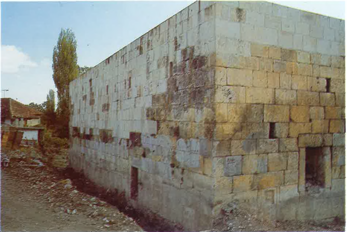
Res. 4: Kuzey cephesi.
