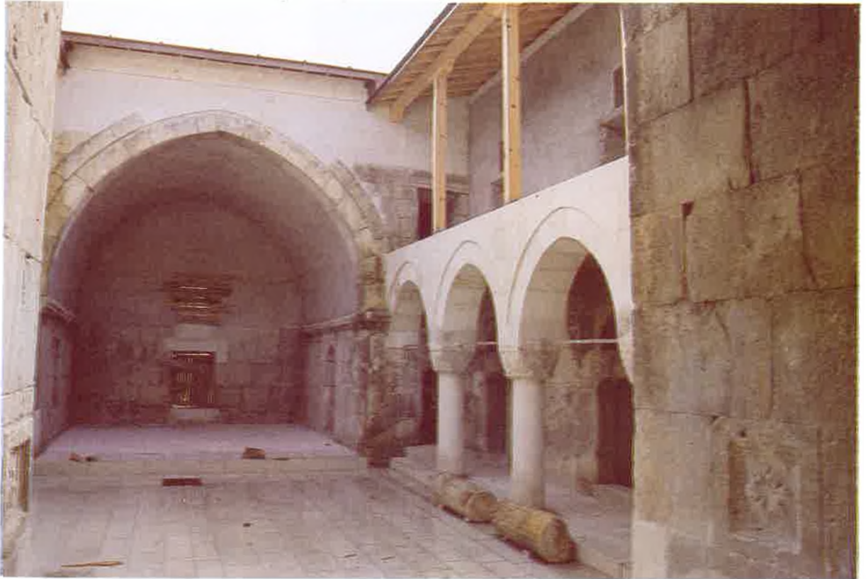
Res. 27: Onarımdan sonra auluya bakış.
