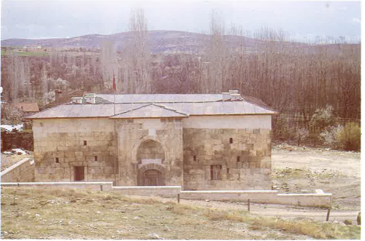
Res. 26: Onarımdan sonra batıdan genel görünüş (1994).
