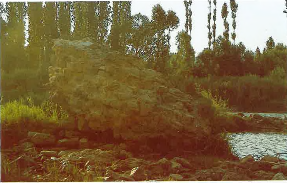
Res. 2: Ertokuş Köprüsü'nün kalıntıları.
