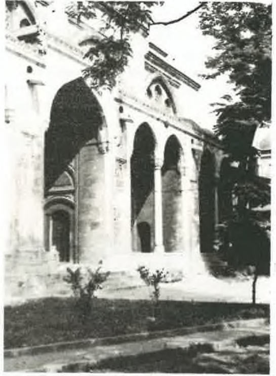
Resim 3. Şehzade Camii batı cephesinden ayrıntı
