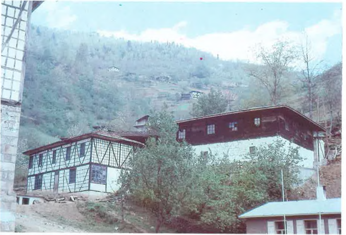
16- Taşçılar Camii genel görünüş
