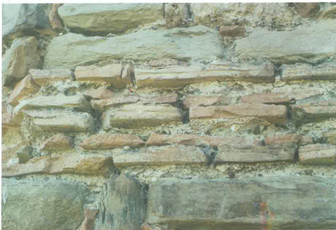
6. Altınyazı surları, güneydeki kule
