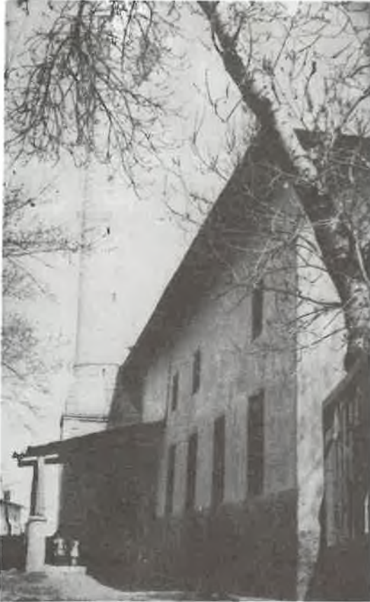
RESİM 2- Pir Hüseyin Bey Cami Batı cephesi
