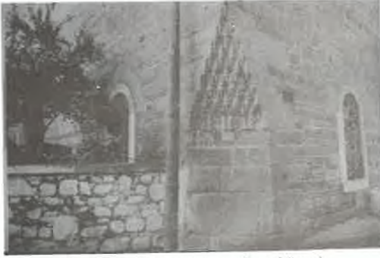
FOTO. 9- Şadırvanlı Camii güneybatı köşesi
