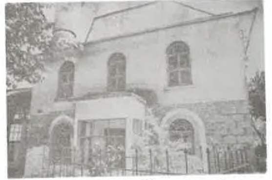
FOTO. 10- Şadırvanlı Camii kuzey cephesi
