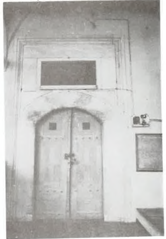
FOTO. 13- Şadırvanlı Camii harime giriş kapı
