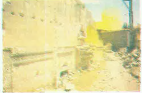
Resim 6 : Hani, Medrese, güney cephe, doğudan görünüş
