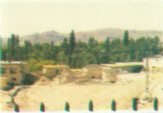
Resim 1 : Hani, Medrese, kuzeyden genel görünüş
