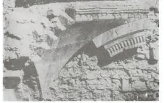
Resim 22 : Hani, Medrese, güneybatı mekân, pandantif kalıntısı (R.H. Ünal'dan)
