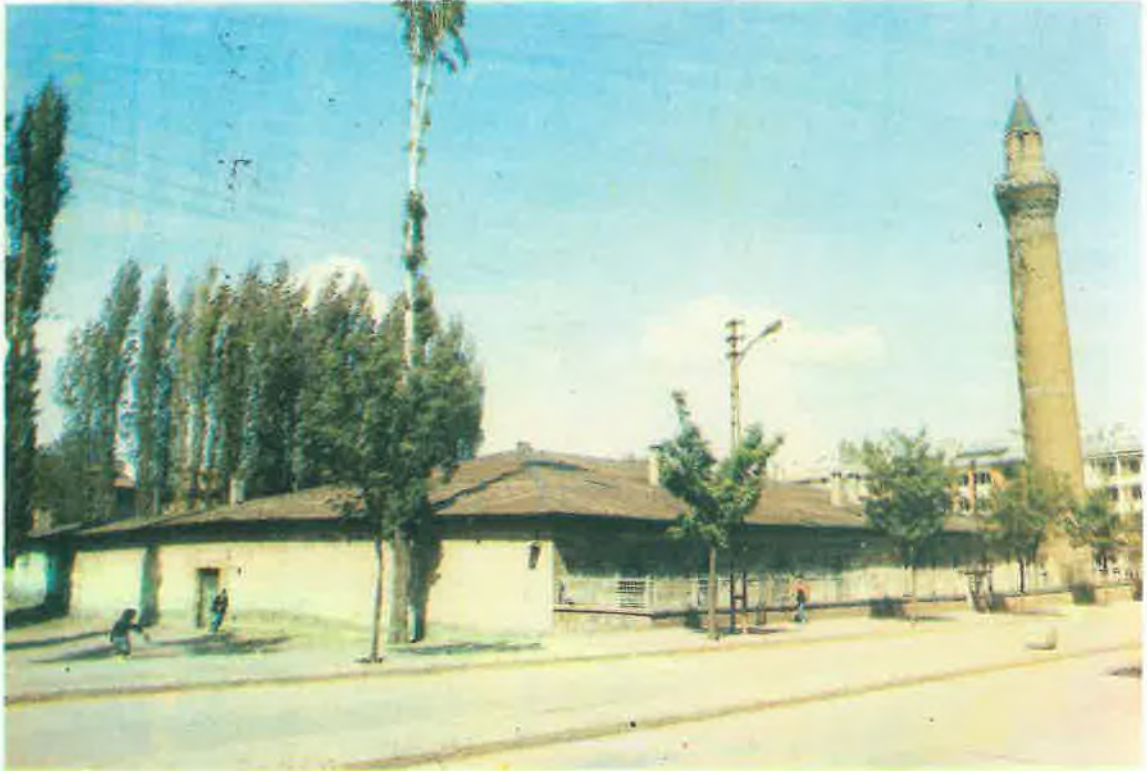
Resim 1 : Sivas Ulu Caminin güney-batıdan görünüşü
