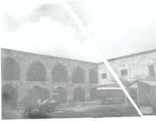
11- Sivas Behram Paşa Hanı avlusu
