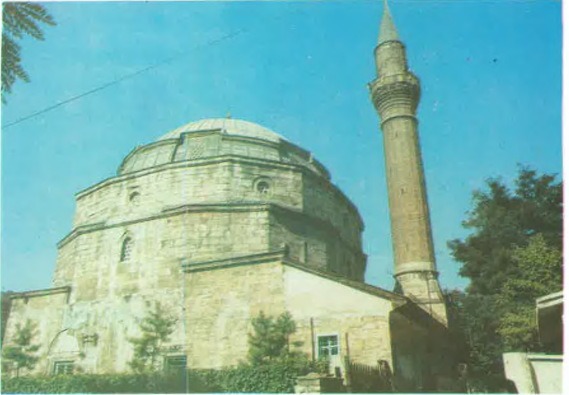
Resim 2 : Sivas Kale Camii'nin doğudan görünüşü
