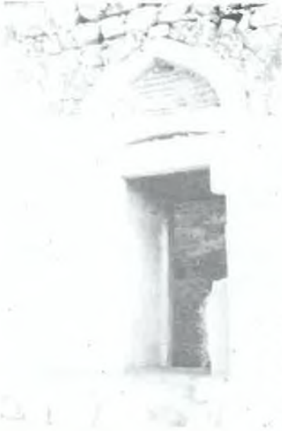
Resim 8 : Güney cephede sağlam kalan pencere
