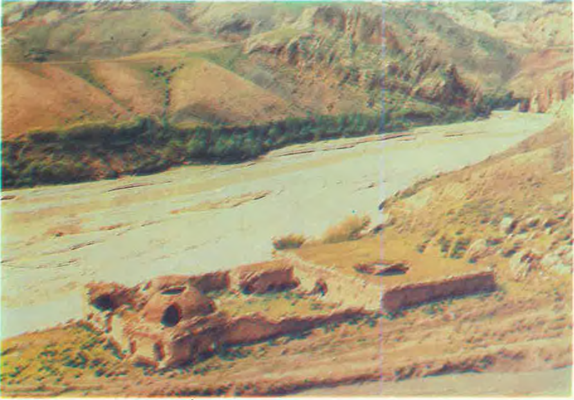
RESİM 1 : Kervansarayın doğudan genel görünüşü.
