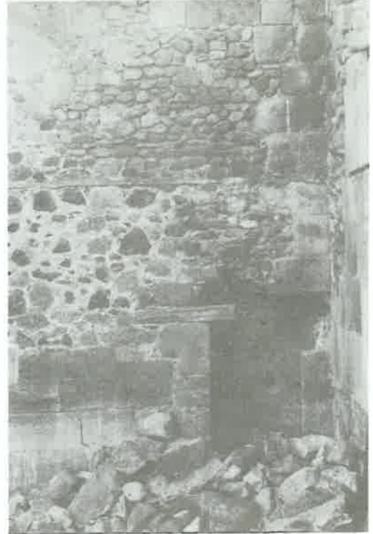
Resim 7 : Aynı kapının dıştan görünüşü.
