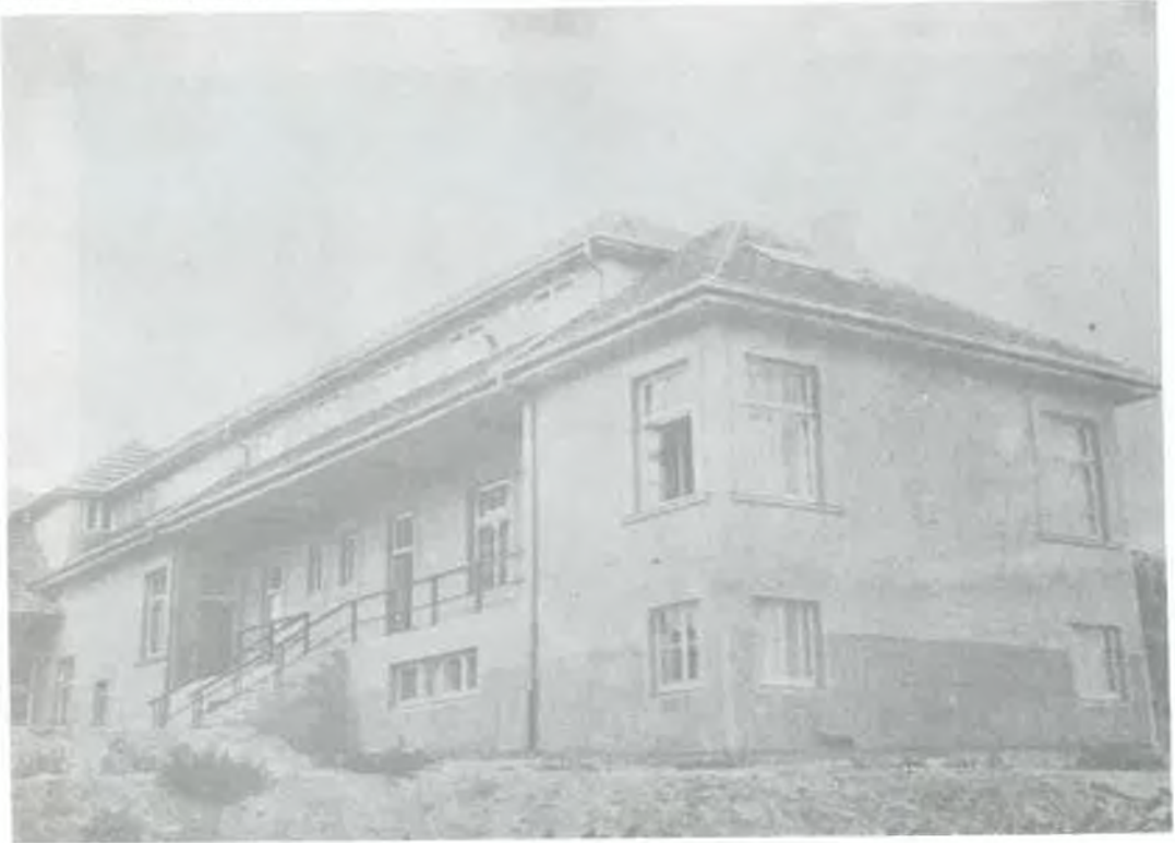
RESİM : 9- Etimesgut'da yatılı okul lojmanı.
