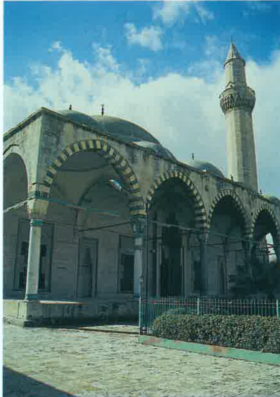
Lev. 34: HALEP, Hüsreviye Külliyesi, Kuzey Cephe (Müderrisoğlu, 2003).
