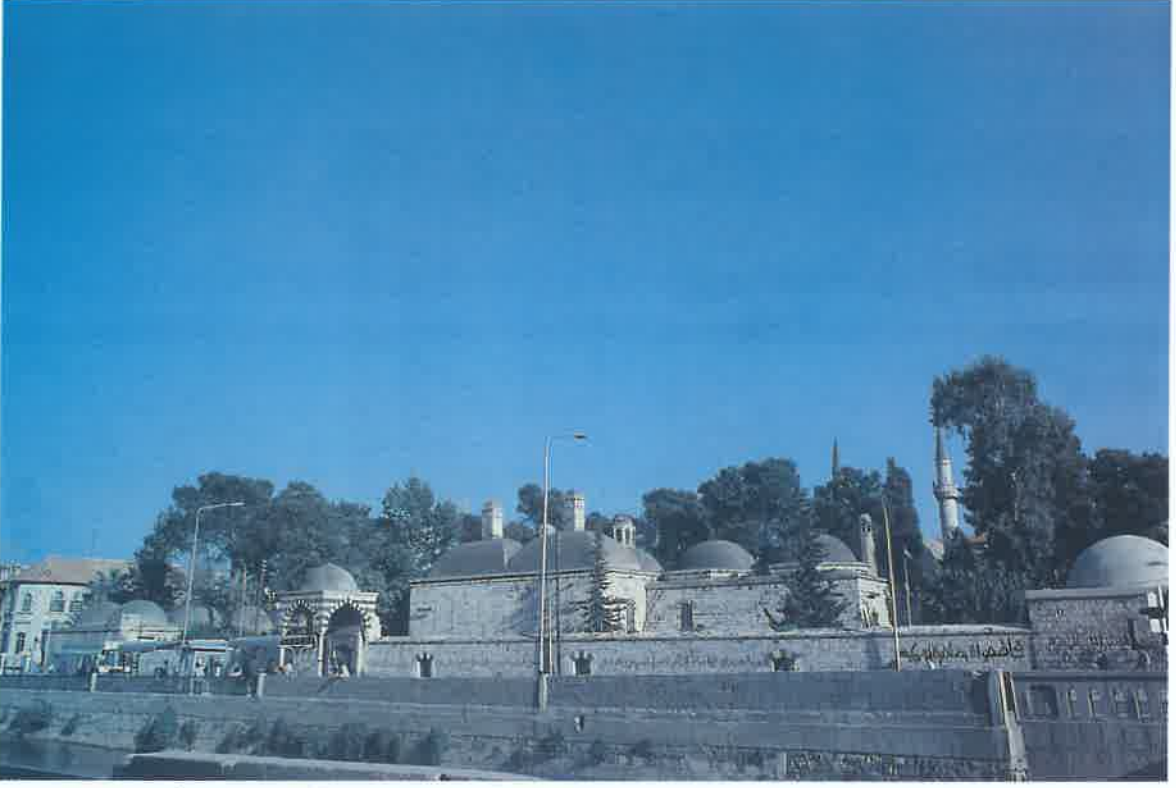
Lev. 21: ŞAM, Süleymaniye Külliyesi. Kuzey Cephe (1990).
