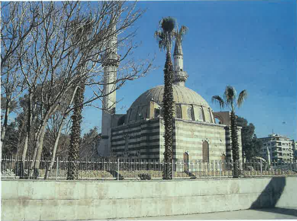
Lev. 10: ŞAM, Süleymaniye Külliyesi, Güney Cephe (Müderrişoğlu 2003).
