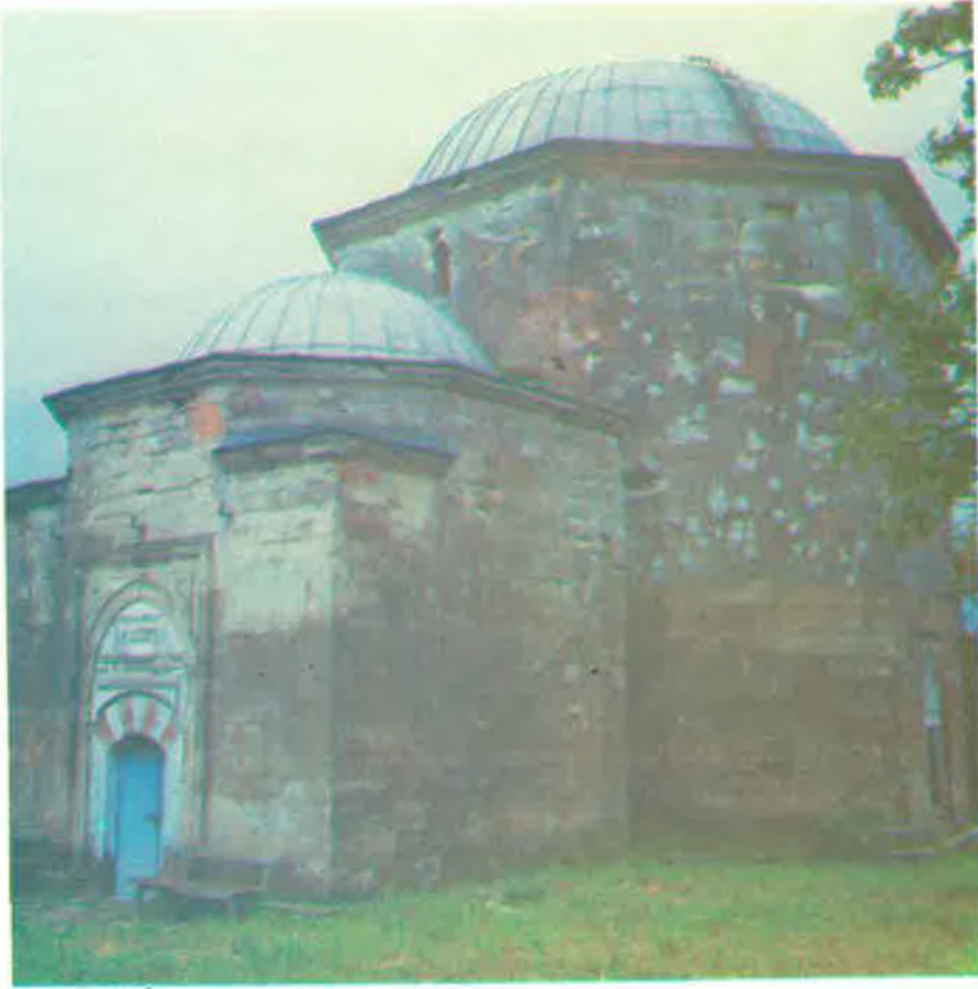
RESİM 5: Türbe ve giriş kısmının görünüşü.
