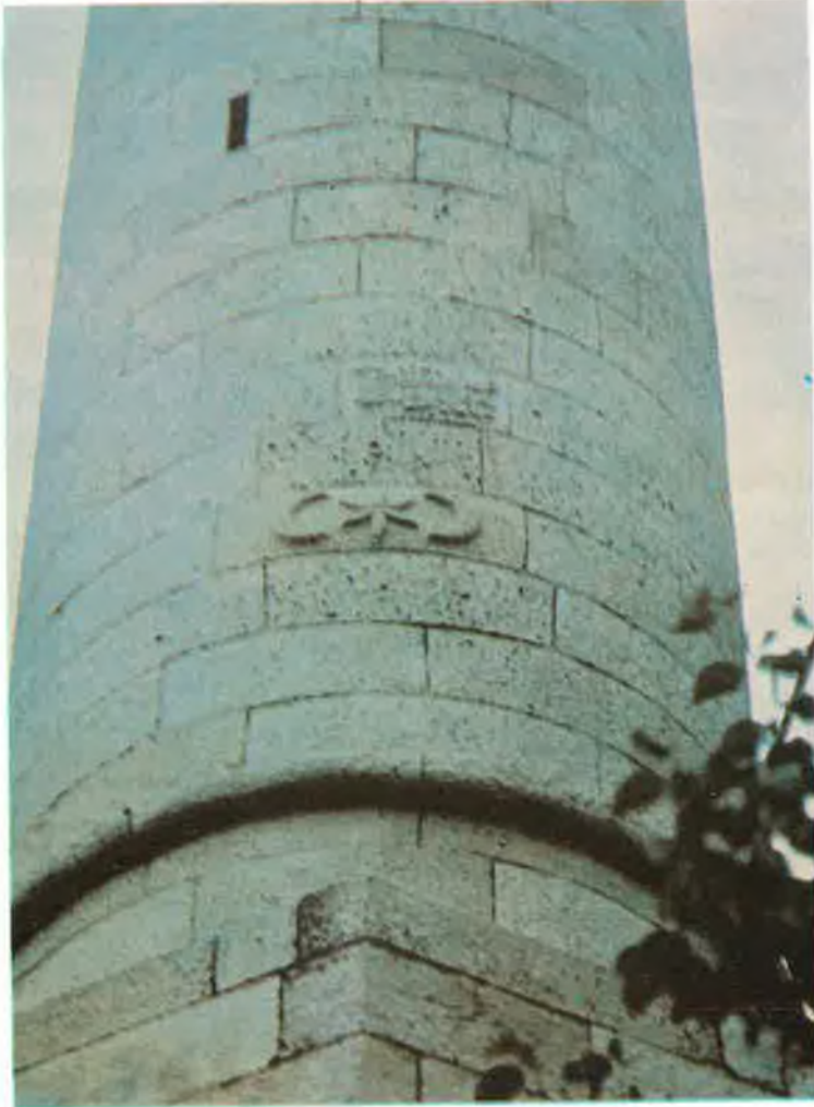
RESİM 16 : Krumovgrad Camisi minarede bulunan kitabe ve ayyıldız.
