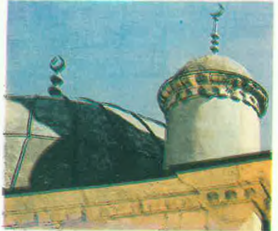
RESİM 12 : Silistre Camii kubbesi ve ağırlık kulelerinden bir görünüş.
