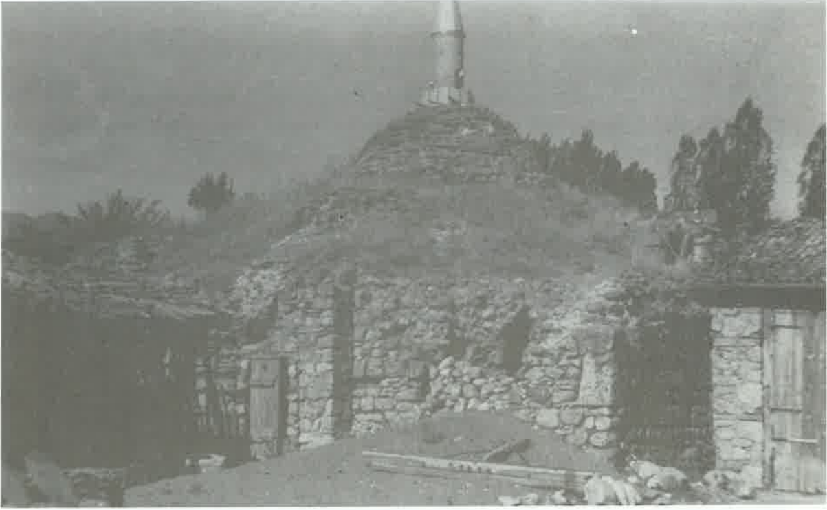
Resim 16: Tek hamam batı (giriş) cephesinden görünüş.
