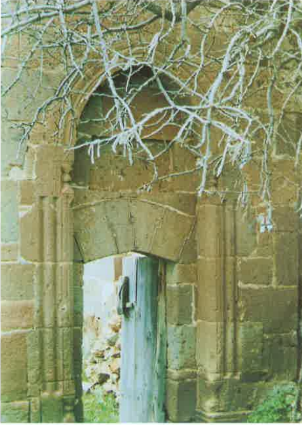
Resim 13: Mescidin doğu duvarında yer alan giriş kapısı.
