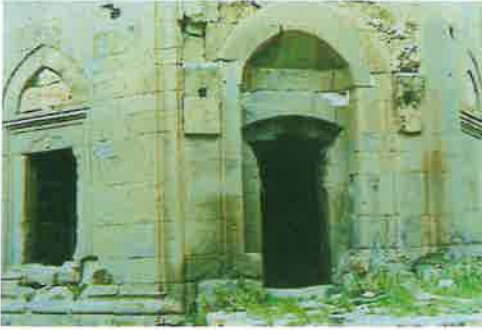
Resim 8a: Sekizgen türbe kapısı önünde kemer üzengiler ve üzerindeki ahşap yuvaları.
