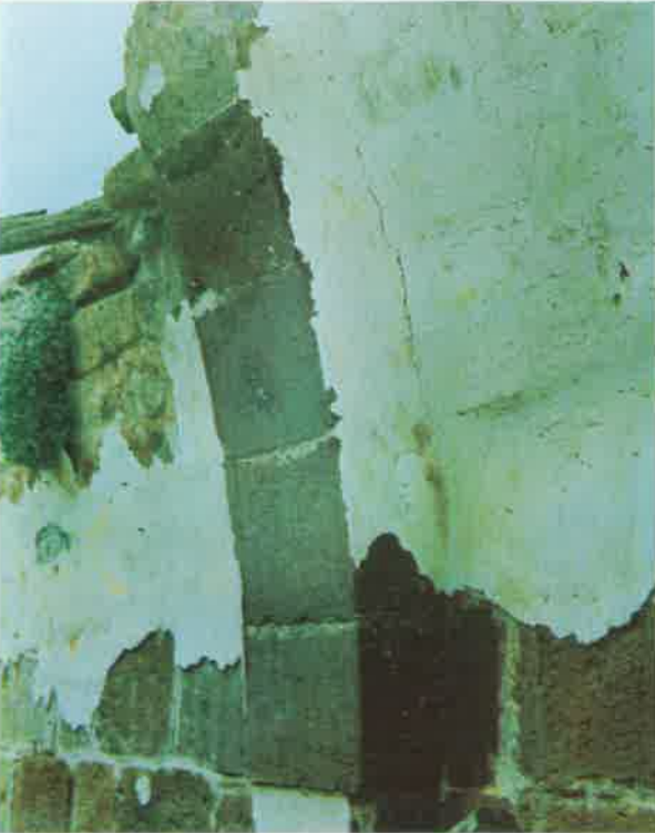
Resim 14: Mescidin yıkılmış olan sivri tonozlu üst örtüsünü taşıyan kemer kalıntısı.
