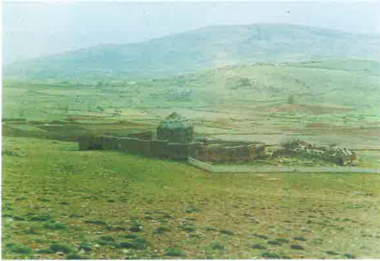
Resim 2: Tekkede arazi meylinde kaynaklanan farklı yükseklikteki duvarlar.
