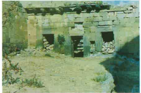
Resim 5: Aşhane (Mutfak)nin batı duvarından bir görünüş.
