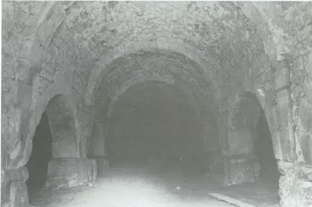
Resim 12: Kervansarayın içten görünüşü.
