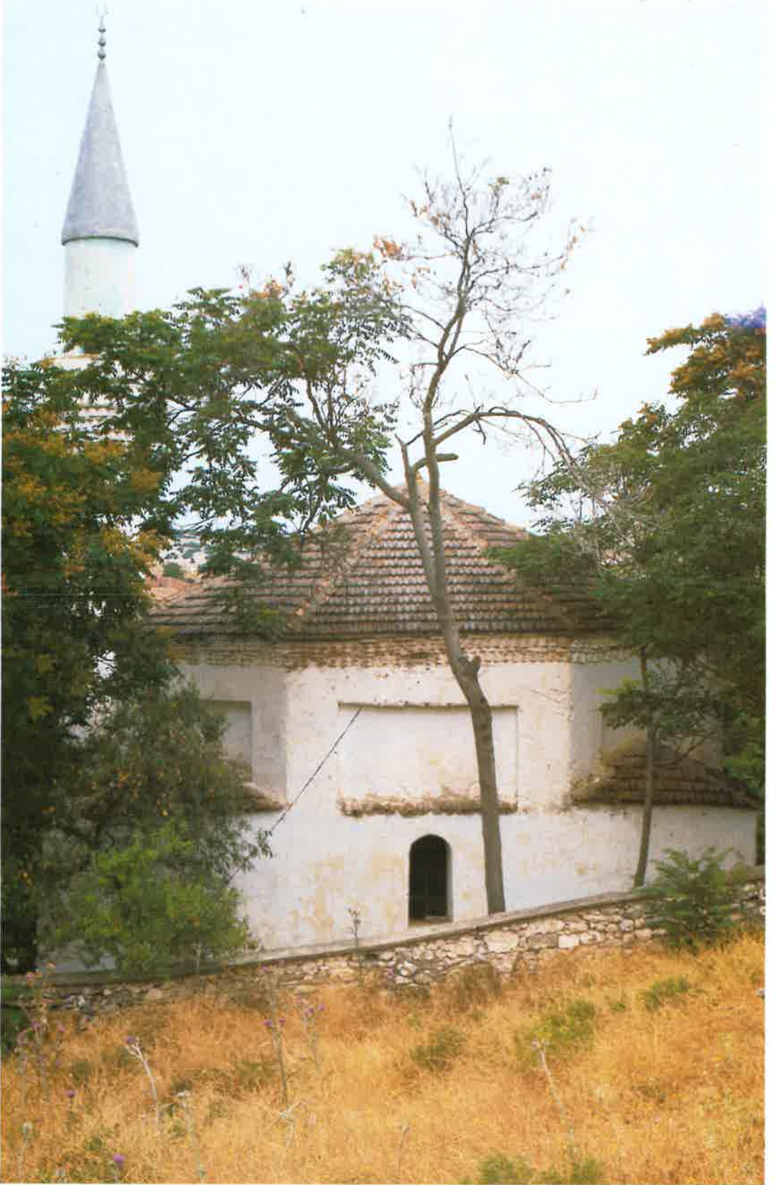
Resim 4: Caminin örtü sisteminin dıştan görünüşü.
