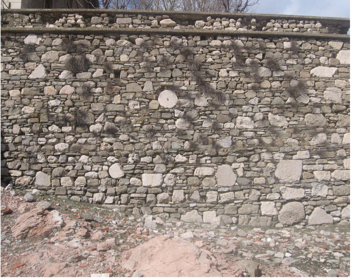
Resim 26: Güney Duvarı, malzeme ayrıntı
