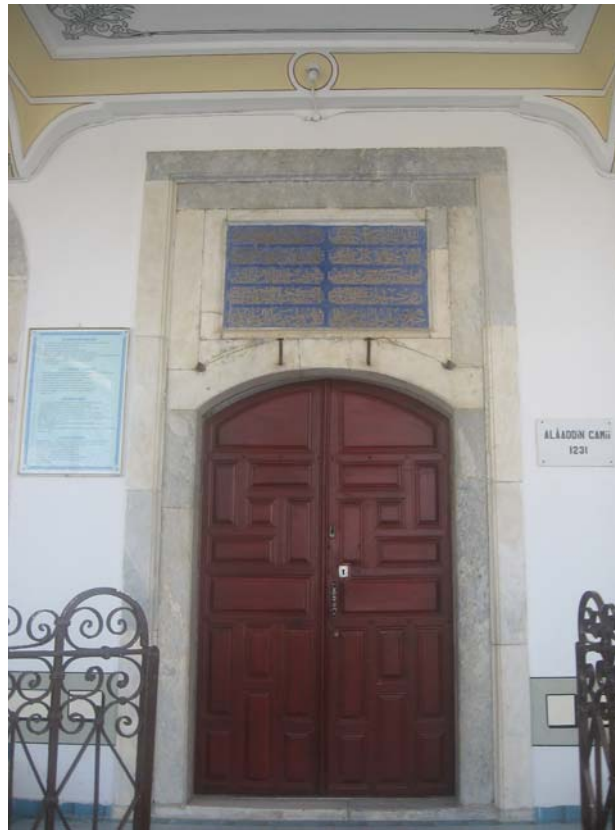
Resim 9: Kuzey Cephe, giriş kapısı
