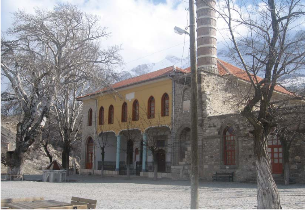
Resim 8: Kuzey Cephe, genel görünüm
