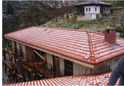
Resim 12: Çatının onarılarak kiremit ile kaplanması
