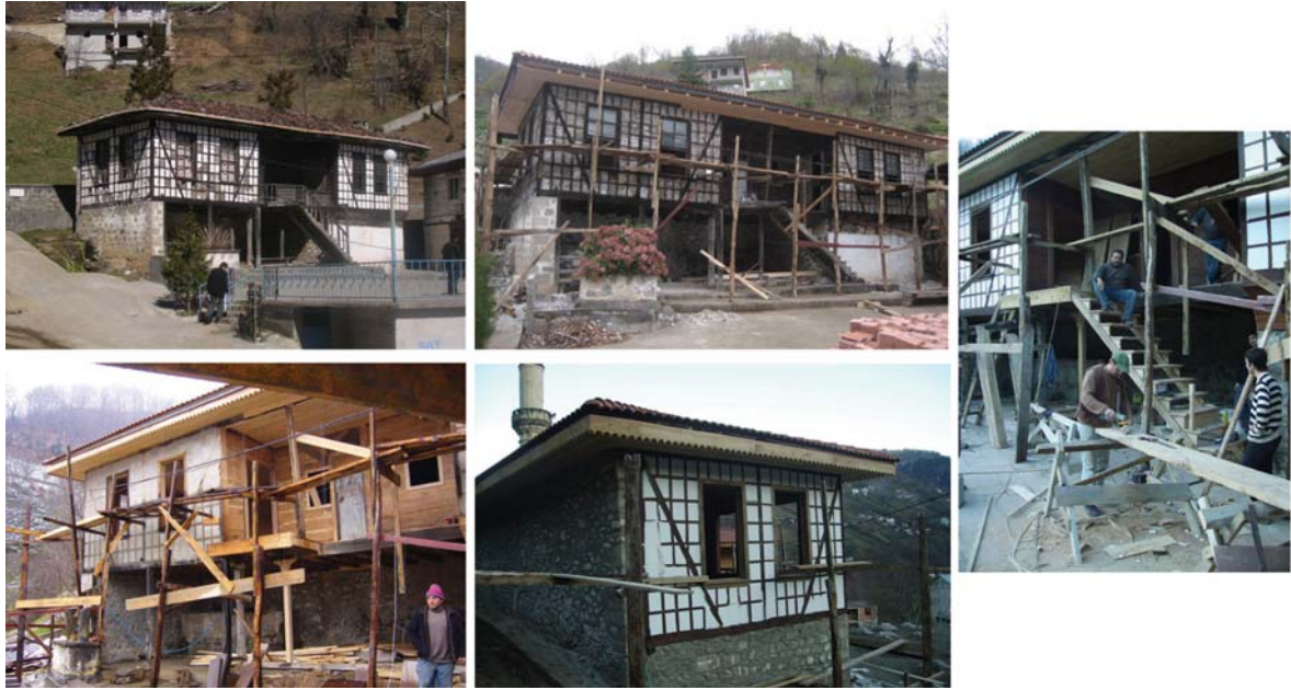
Resim 15: Medrese binasının duvarlarının onarımı
