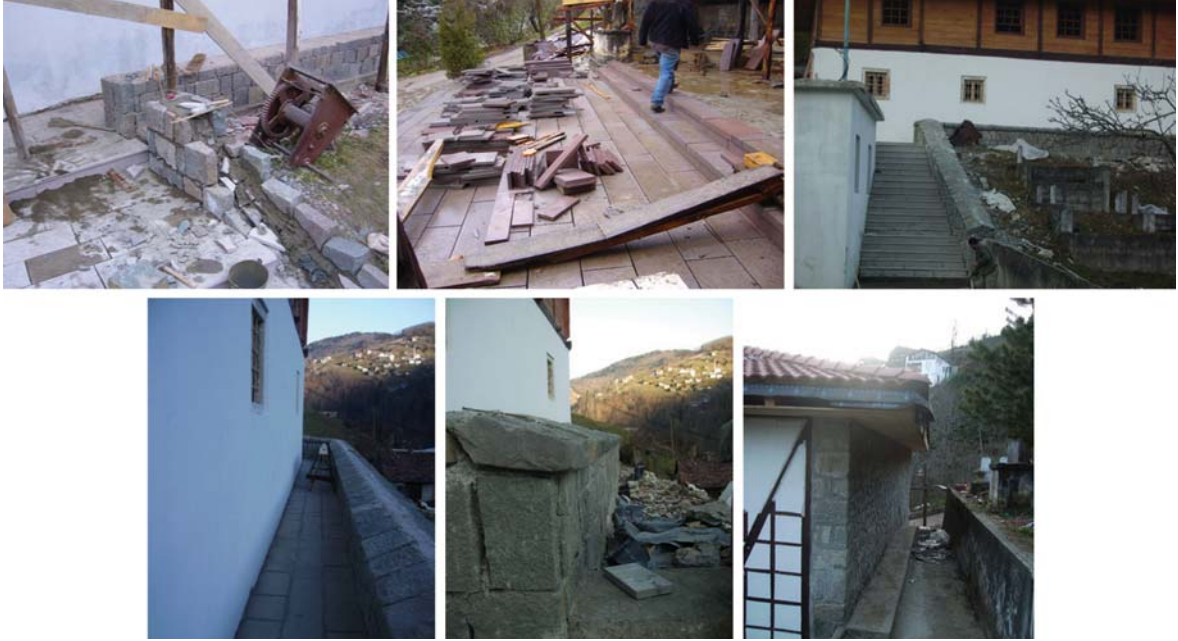
Resim 20: Çevre düzenlenmesinin yapımı
