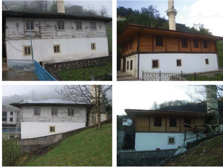
Resim 14 Onarım öncesi ve sonrası duvarlar
