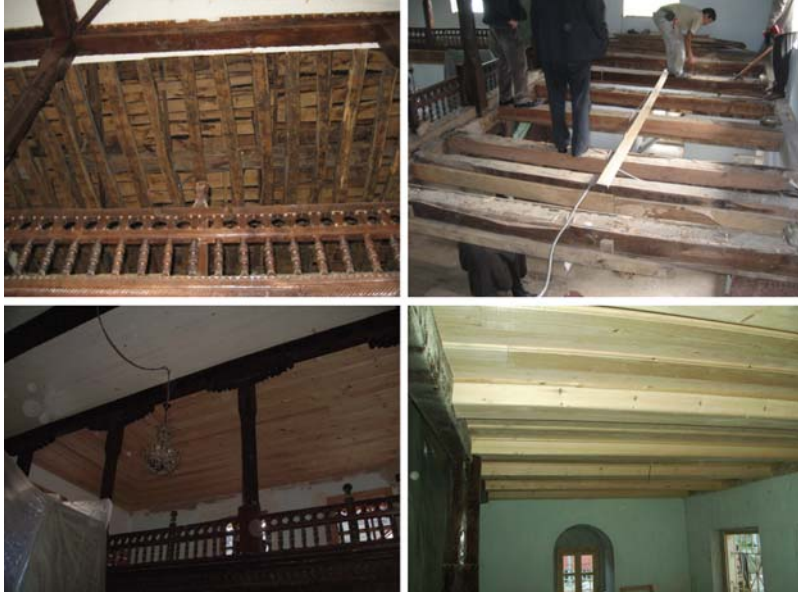
Resim 16: Mahfil tavan ve döşemesinin onarım-yenilenmesi
