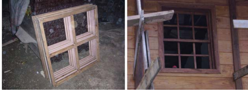
Resim 17: Pencere doğramalarının yenilenmesi
