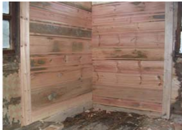
Resim 13: Boğaz geçme duvarların bozuk olan bölümlerinin onarım ve yenilenmesi
