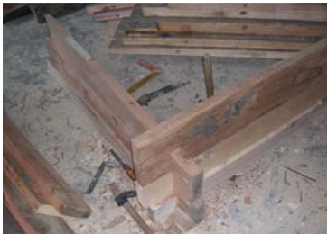
Resim 13: Boğaz geçme duvarların bozuk olan bölümlerinin onarım ve yenilenmesi
