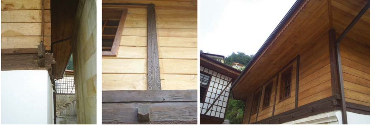
Resim 3: Boğaz geçme ahşap duvarlar
