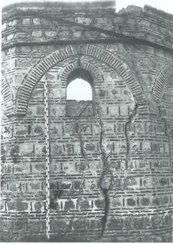
FOTO 20. DOĞU CEPHESİ ( J-K ) ( 1997 ).
