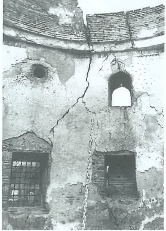
FOTO 39. İÇ GÖRÜNÜM (A-M-L) (1997).
