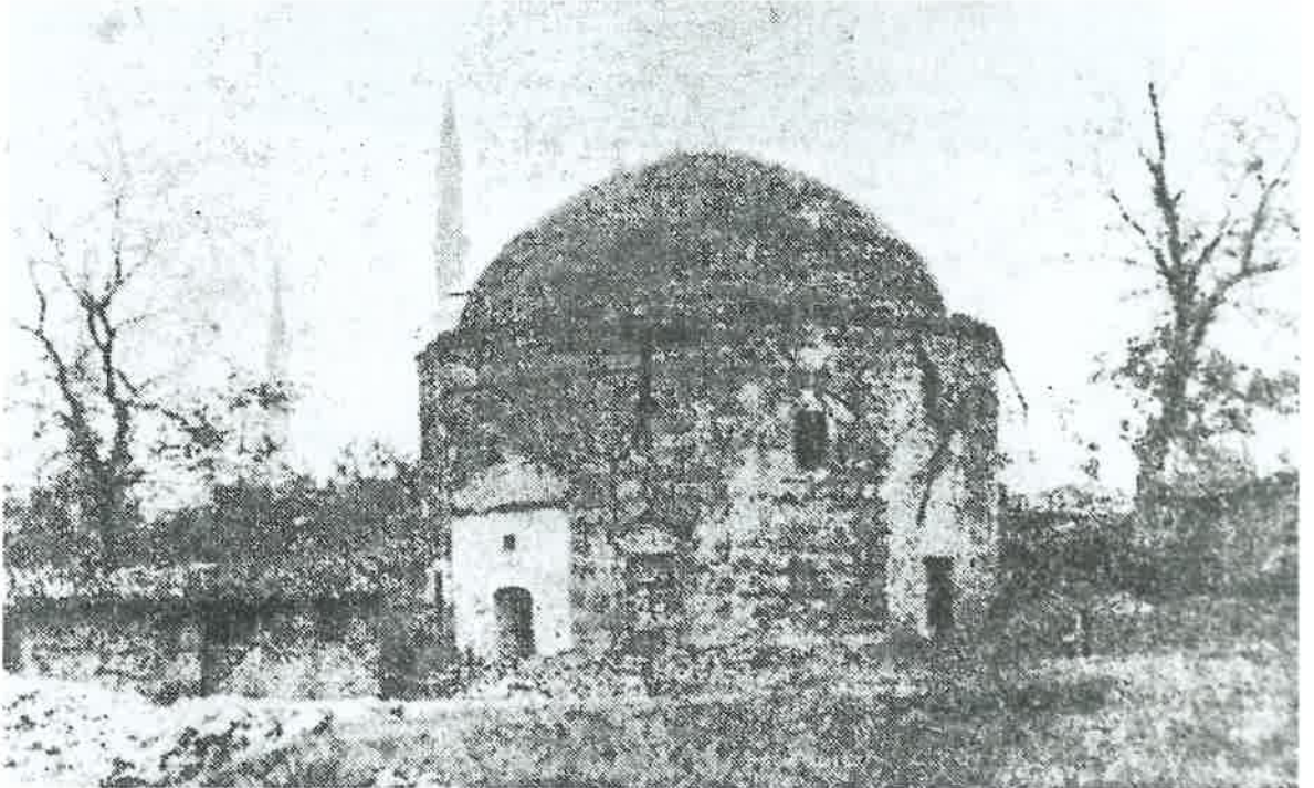
FOTO 2- TÜTÜNSÜZ BABA TÜRBEŞİ KUBBE KURŞUNLARI TOPLATILDIKTAN SONRA, GERGİ DEMİRLERİ PATLAMIS ŞEKLİYLE, 1953 ZELZELESİNDEN SONRAKİ HALİ (1957. H.Y. İDRİSOĞLU).
