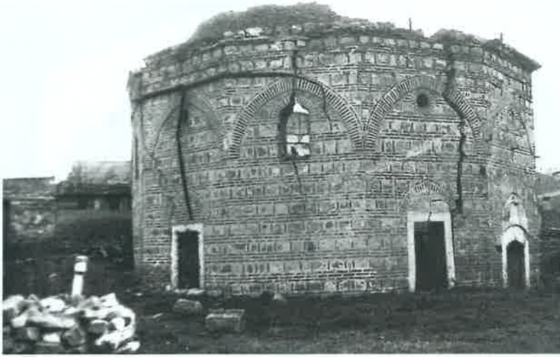
FOTO 9. KUZEY CEPHESİ (L-M-A-K) (1997).
