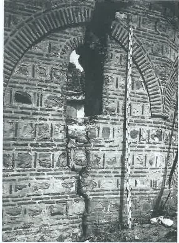
FOTO 29. KUZEY CEPHESİ ( L-M ) (1997 ).
