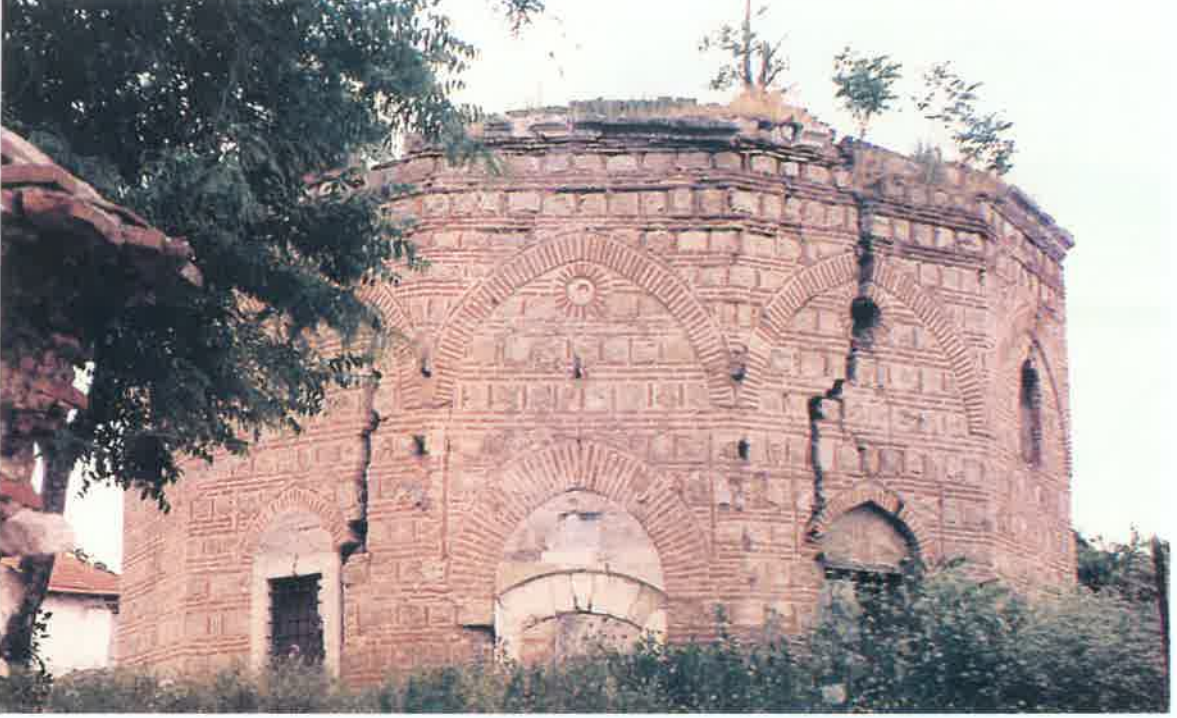
FOTO 3. YAPININ BUGÜNKÜ DURUMU (2002).
