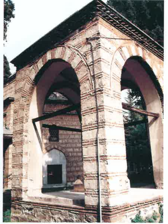
Resim: 10 Bursa Umurbey Türbesi.
