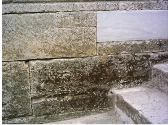
Şekil 19. Edirne Selimiye Camii Kuzey Cephe tretuvar üstü ve merdiven girişi cephesinde yosunlaşma ve bakteri şeklinde oluşan tahribat.
