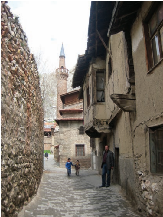
Fotoğraf 1. Konut giriş cephesi
