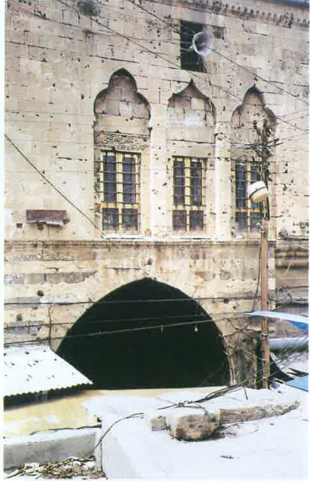
Resim 5: Gümrük Hanı giriş eyvanı ve mescid cephesi.
