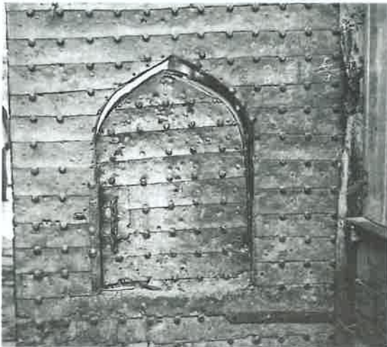
Resim 9: Gümrük Hanı kapı kanadı.
