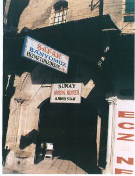
Resim 45: Şark İşhanı portal.
