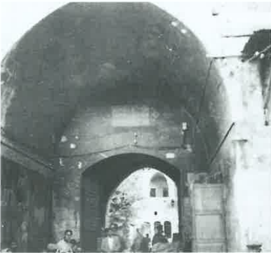
Resim 6: Gümrük Hanı giriş eyvanı.
