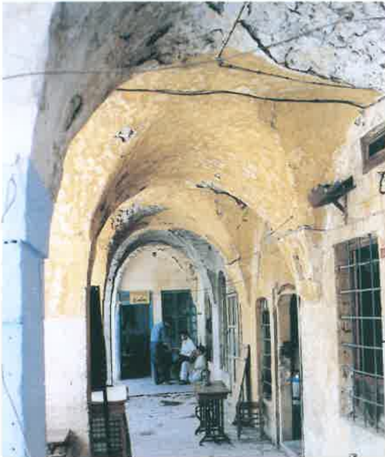
Resim 39: Hacı Kamil Hanı birinci kat doğu revakı.
