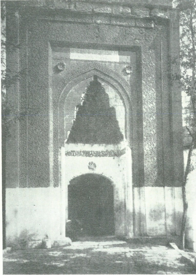
6 — KAYSERİ: Hund Camii medhali (Selçuk Devri). Kapı da, camiin kendisi gibi iyi vaziyettedir. Kaide kısmındaki beyaz sıva ve badanalar temizlenmelidir.
