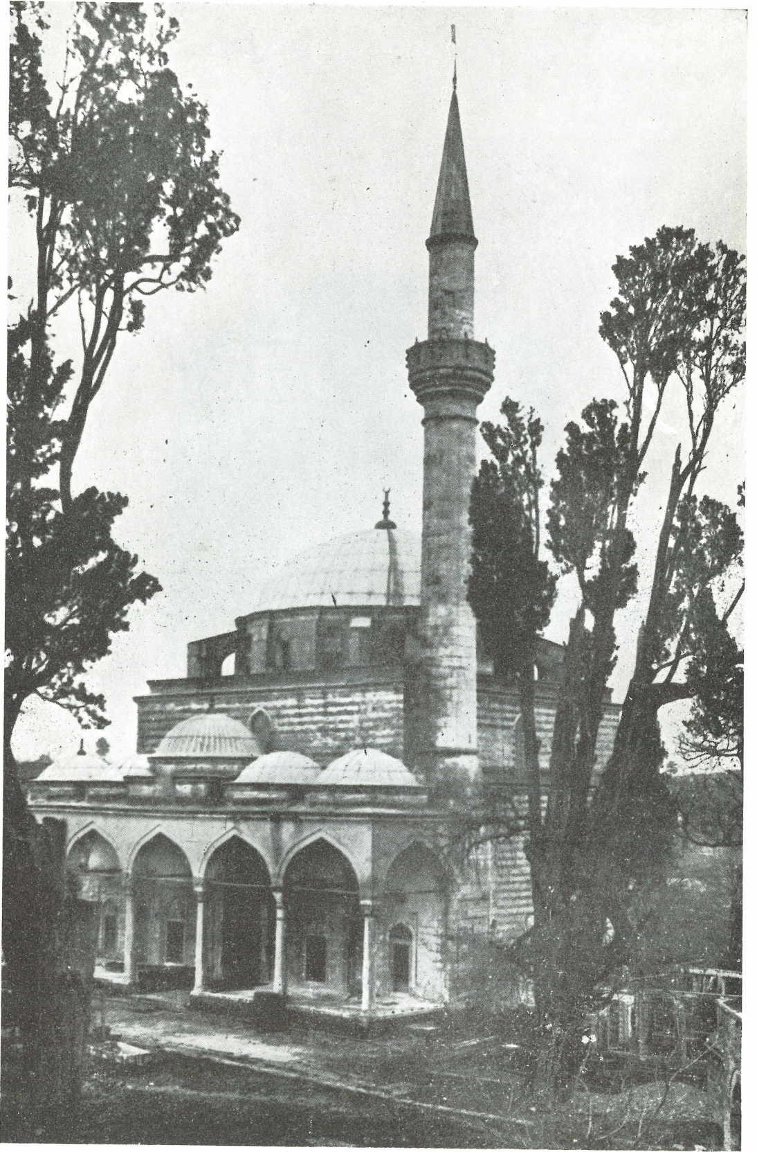
1 — Silivri'deki Hadım İbrahim Paşa Camii
