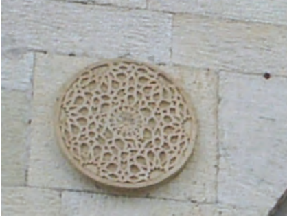
a-Giriş kapısı sol köşe (kuzeybatı cephesi)
