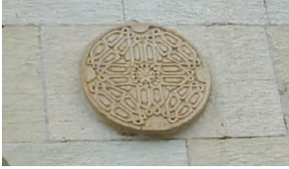
c- Giriş kapı sağ köşe (kuzeybatı cephesi)
