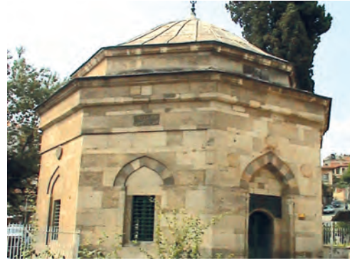
b- Kuzeydoğu Cephesi [Fot: İsmet Çalık]
