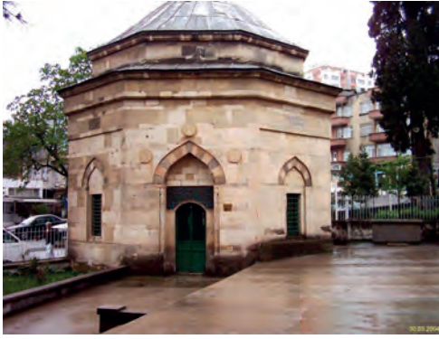
a- Kuzey Cephesi
