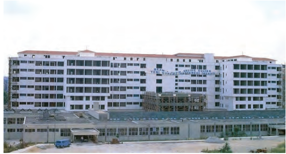
Resim 6. Yeni hastane binasının inşaatı
