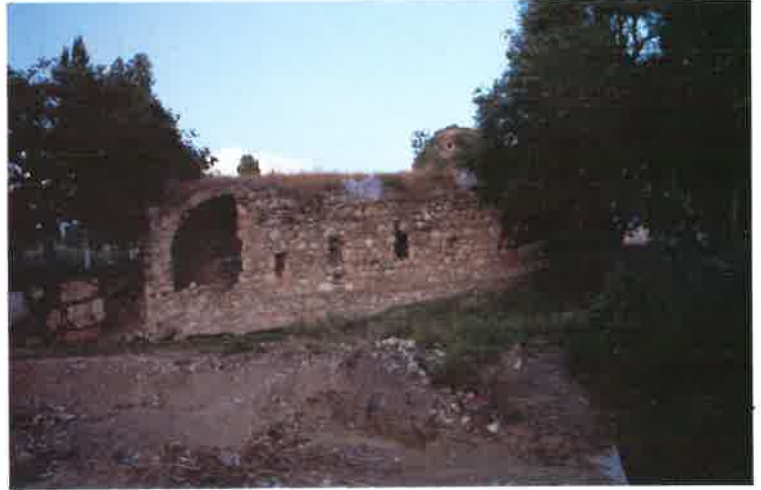
Resim 30: Yolpınar Köyünde bulunan Kasım Paşa Medresesi.
