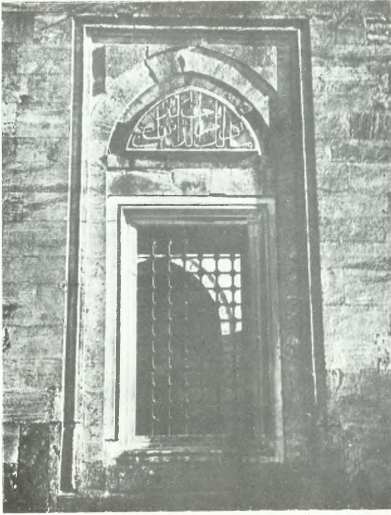
26 — Harici cephe pencereleri üstündeki tezyinat. Yeşil porfir üzerine kakma olarak mermerle yazılar yazılmıştır. Pencere molürleri daha ziyade Bursa uslubuna yakındır.
