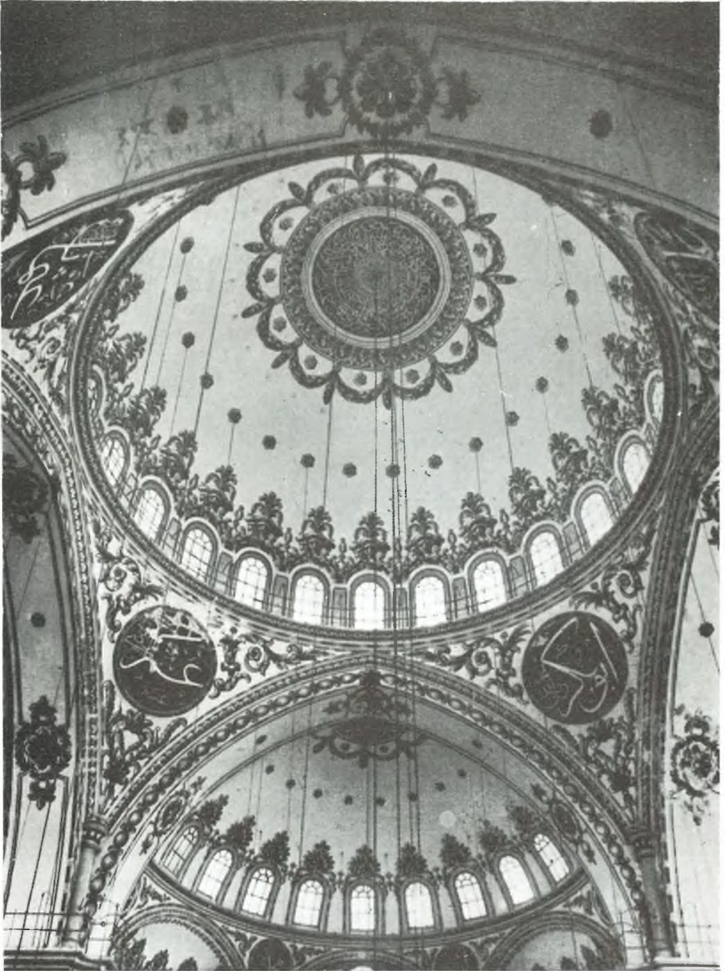
42 — Bugünkü Fatih Camiinin kubbe ve büyük kemerleri. Bu kemerler klâsik devir kemerlerinden daha sivridir. Silmeler ve alika nihayet- lerindeki barok üslûbunun şekilleri ile dairevî tali kemerler; gözümüze yabancı bir tesir vermektedir.
