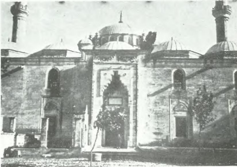
28 — Fatih Camii revaklı avlusunun esas kapı cephesi. Bu cephe pencerelerinin üstlerindeki kemerlerin içi porfir üzerine mermerle kakma olarak nefis sülüs hatla yazılar yazılmıştır. Pencereilerin etrafı kâmilan molürlüdür.
