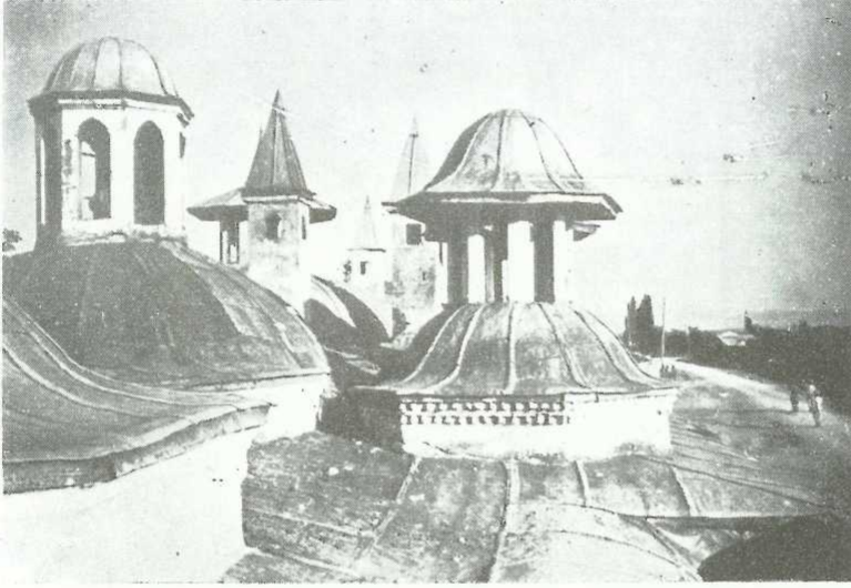
59 — Gebze: Çoban Mustafa Paşanın meşhur imaretinde ocak ve vantilasyon bacaları. (XVI ncı asır).
