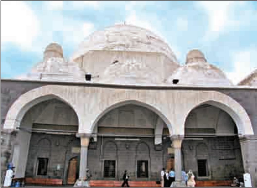
Şekil 5. Camii güney cephesi (Avlu kuzey görünüşü).
