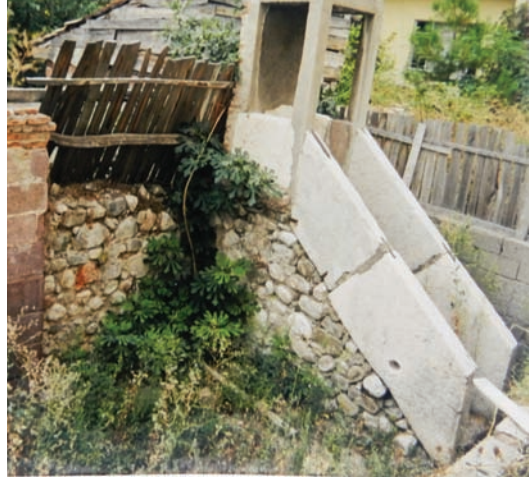
Resim. 3 Vezirköprü Köprülü Mehmed Paşa Namazgâhı Kuzey Doğudan (2008 Restorasyon Öncesi - 2003).
