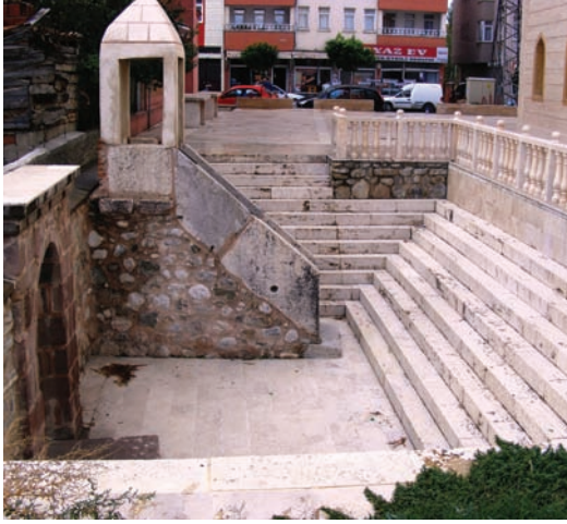
Resim. 2 Vezirköprü Köprülü Mehmed Paşa Namazgâhı Doğudan Genel Görünüş. (2008 Restorasyon Sonrası).
