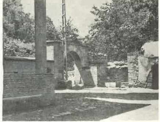
RESİM: 3 Camii avlu duvarı, güney giriş kapısı.
