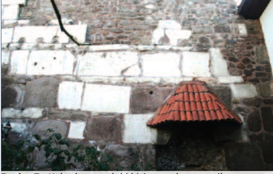
Resim 7: Kale duvarındaki kiriş yuvaları ve mihrap.
